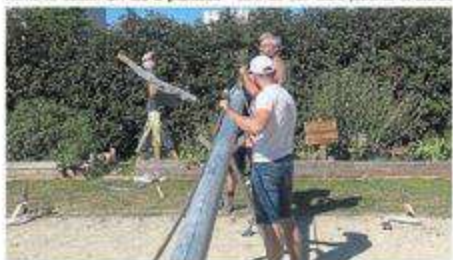
Au centre du chapiteau, deux mâts soutiennent la structure. Ils en sont la pièce maîtresse. (Photo: Gaël Frenck)
