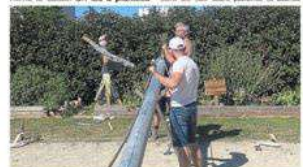
Au centre du chapiteau, deux mâts soutiennent la structure. Ils ont été plantés à l'avance.
